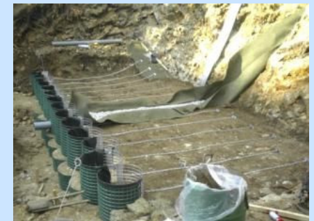
盛土へチェーンおよび支圧板設置
