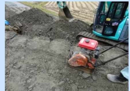
円筒金網近傍および上部の敷均し，転圧
