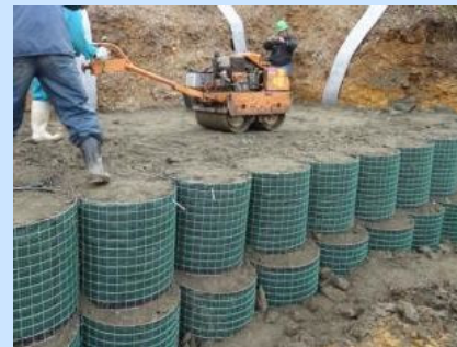
盛土の敷均し，転圧
