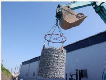
かご丸くん碎石型は直吊り金具を用いることで、バックホウ1台で碎石の投入から現場での据え付けまでの作業を完結できます。これにより専門の職人による人力での作業を多く必要とする従来の碎石かご工法と比較して安全性、施工性の大幅な改善を実現させることができました。
