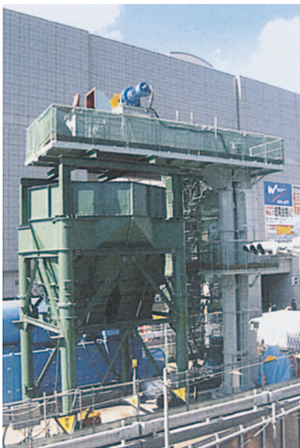
現場設置状況
