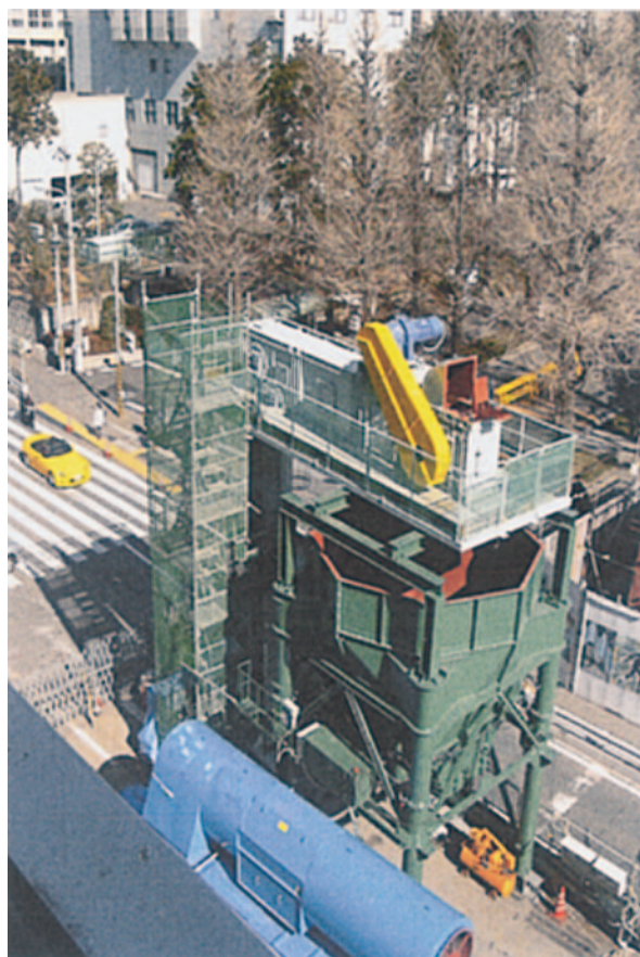
現場設置状況
